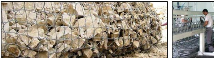
Eboulement contenu par filet ELITE® et fabrication en usine
