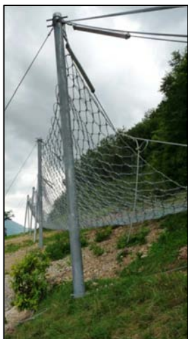
Ecran ELITE® : filet en amont, dissipateurs répartis, pied de poteau sans fondations lourdes.
